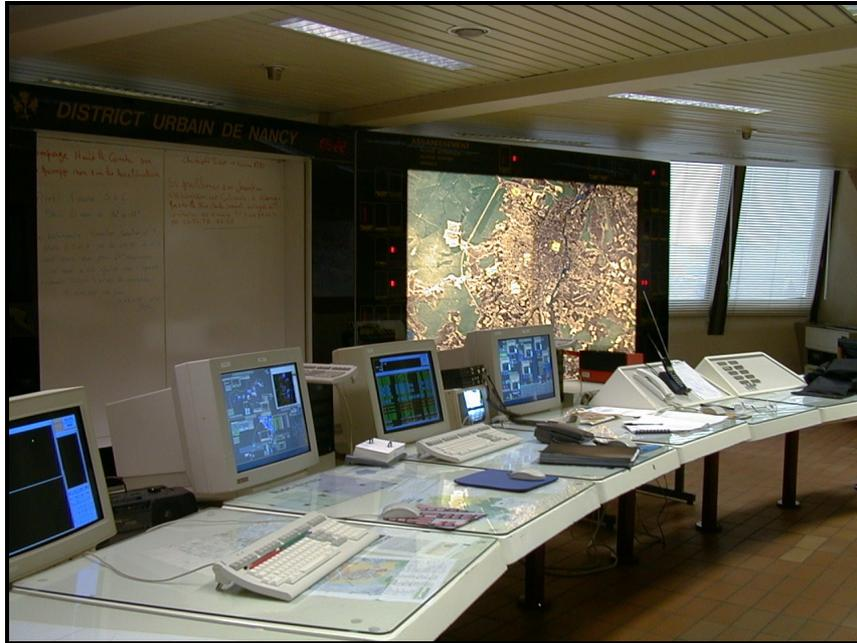
Photo 1 : Centre de télégestion de la Communauté Urbaine du Grand Nancy. Les informations provenant du radar modifient l'affichage des écrans de télésurveillance ou le fil de l'eau.
